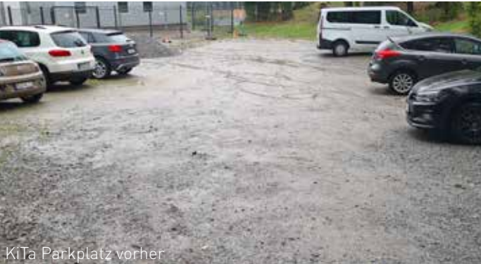
KiTa Parkplatz vorher
