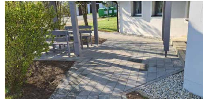
Als eine der ersten Maßnahmen in diesem Jahr wurde der Zugangsbereich hin zur Eingangstüre renoviert. Wegen massiver Setzungen musste erst der Untergrund saniert werden, ehe im Anschluss das neue Pflaster verlegt werden konnte. Außerdem wurde die Pflasterfläche seitlich mit Randsteinen eingefasst, was vorher nicht der Fall war.
